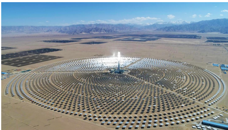
图：青海海西州鲁能多能互补集成优化国家示范工程
